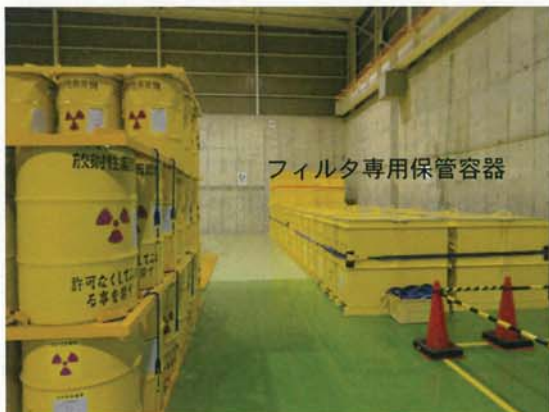
200リットルドラム缶及びフィルタ専用保管容器の保管状況
